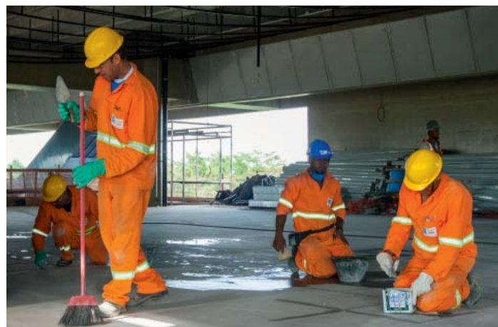
Operários finalizam piso de granito da Estação Aeroporto-Guarulhos
